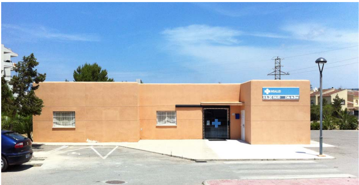
Fotografía 1. Fachada frontal de la edificación actual.
