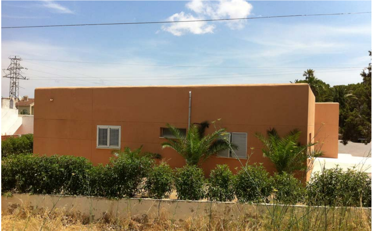
Fotografía 2. Fachada oeste de la edificación actual.
