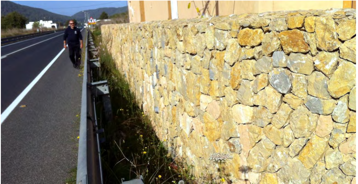
PASO ESTRECHO MURO PIEDRA
