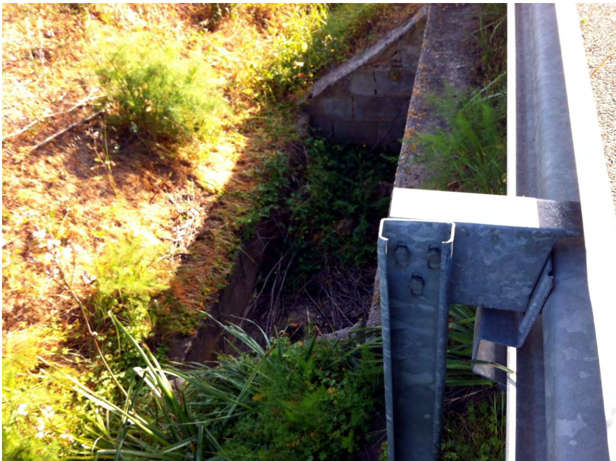
DETALLE PASO AGUAS BAJO CARRETERA
