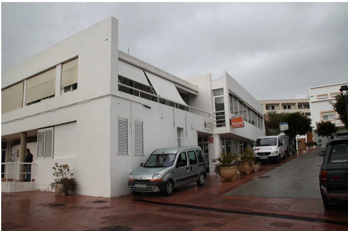
Vista de la fachada lateral.
