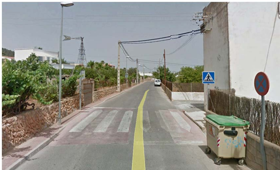
Imagen 14. Recorrido por C/del Pica-Soques. Centro de transformación.
