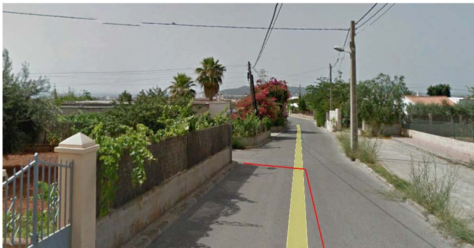
Imagen 34. Cruce C/del Dolfi con C/de les Truites.
