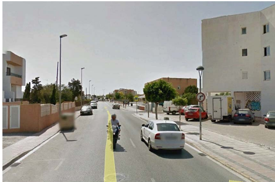
Imagen 28. Proximidades Final Tramo 4.8- Avda. San Agustín-C/de Huelva (I).
