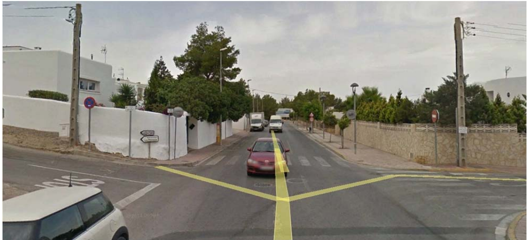
Imagen 20. Final Tramo 4.4- Avda. San Agustín-C/Burgos (E).
