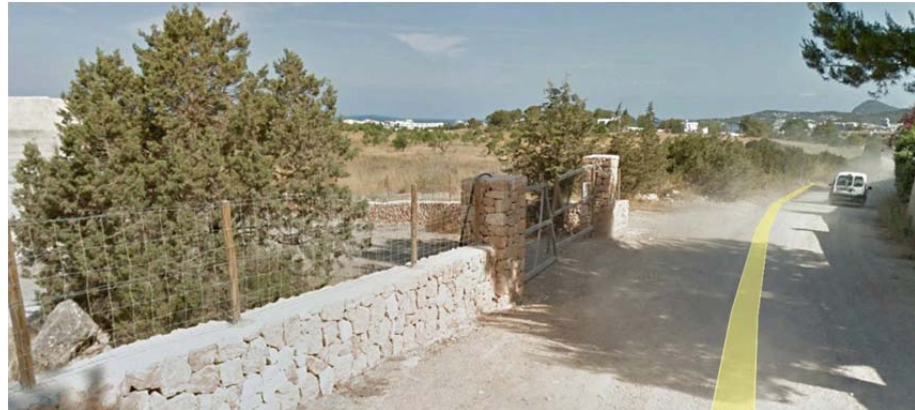
Imagen 1. Tramo 1-Salida parcela Depósito Cala de Bou hacia C/Algalda.
