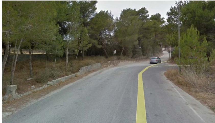
Imagen 13-b. Tramo 4.22 en Avda. San Agustín.
