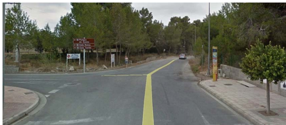
Imagen 13. Cruce T en Avda. San Agustn con C/des Torri.
