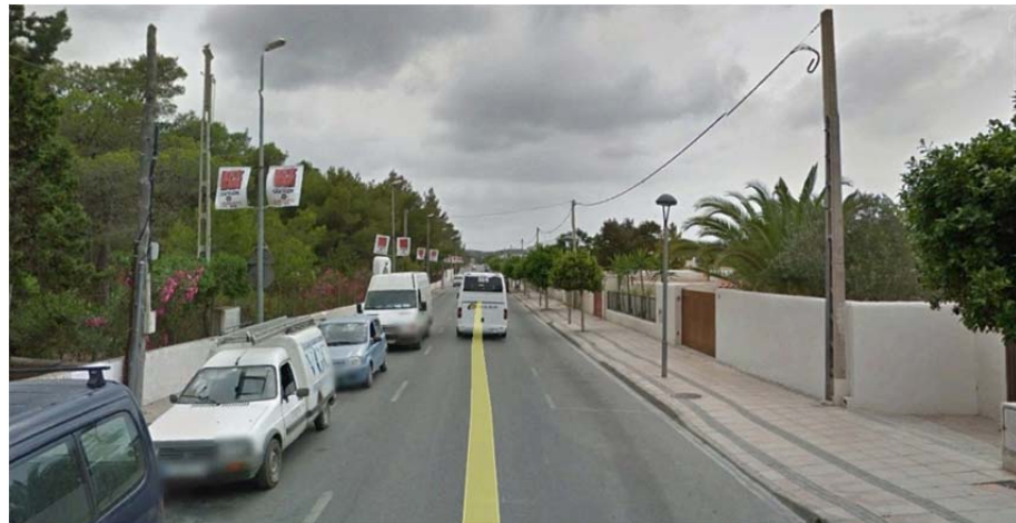
Imagen 5-b. Tramo 4.13 en Avda. San Agustín.
