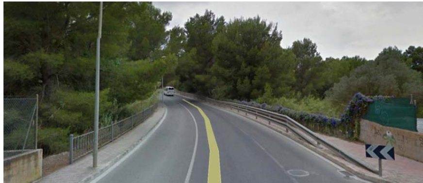
Imagen 10-d. Torrente en Tramo 4.19 en Avda. San Agustín.
