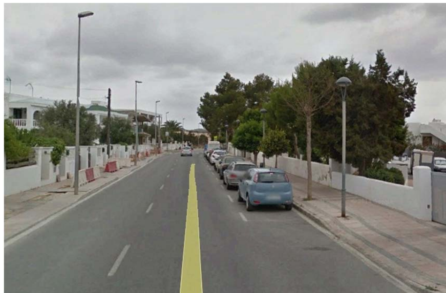
Imagen 11-b. Tramo 4.20 en Avda. San Agustín.
