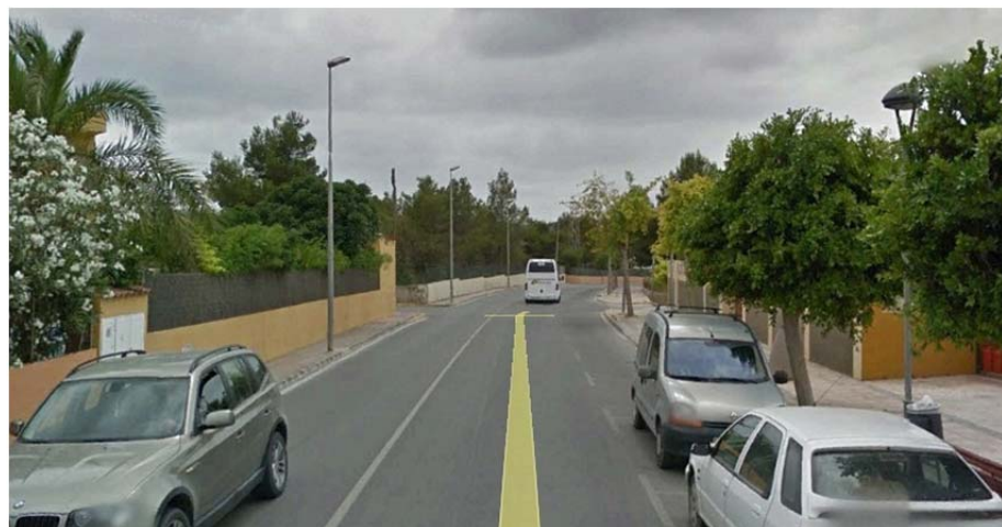
Imagen 9-b. Tramo 4.18 en Avda. San Agustín.
