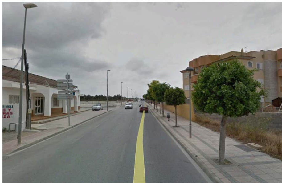
Imagen 1-b. Tramo 4.10 en Avda. San Agustín.
