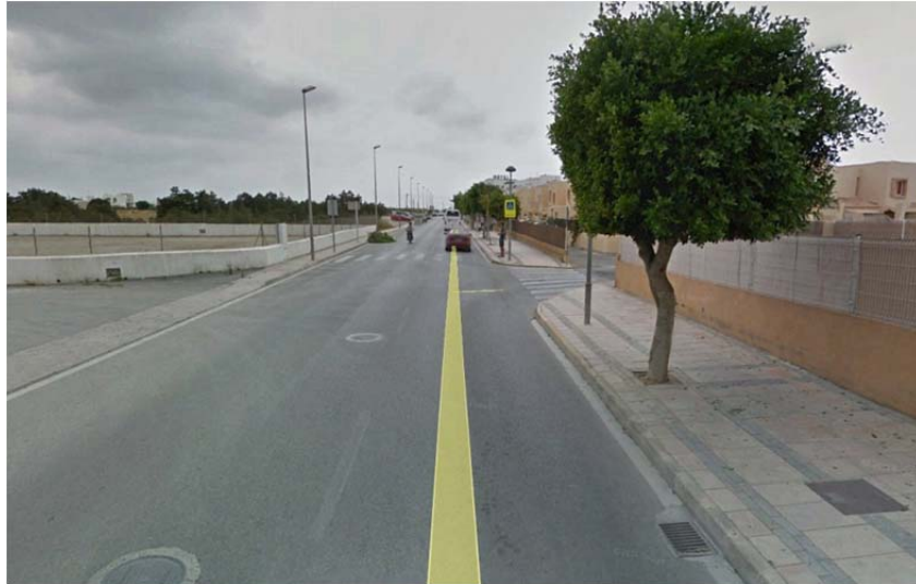
Imagen 2. Cruce K en Avda. San Agustín con C/de la Coruña
