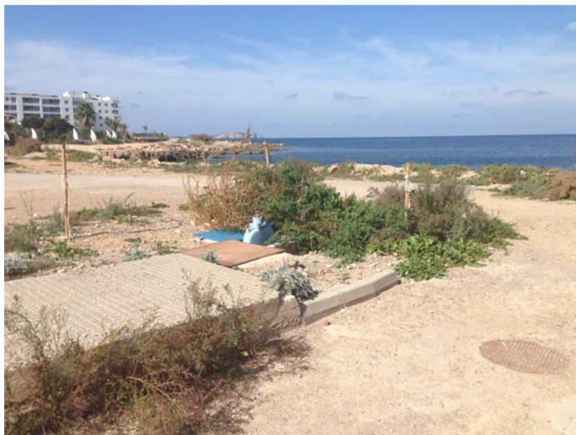
PUNTO DE UNIÓN DEL EMISARIO TERRESTRE-MARÍTIMO
