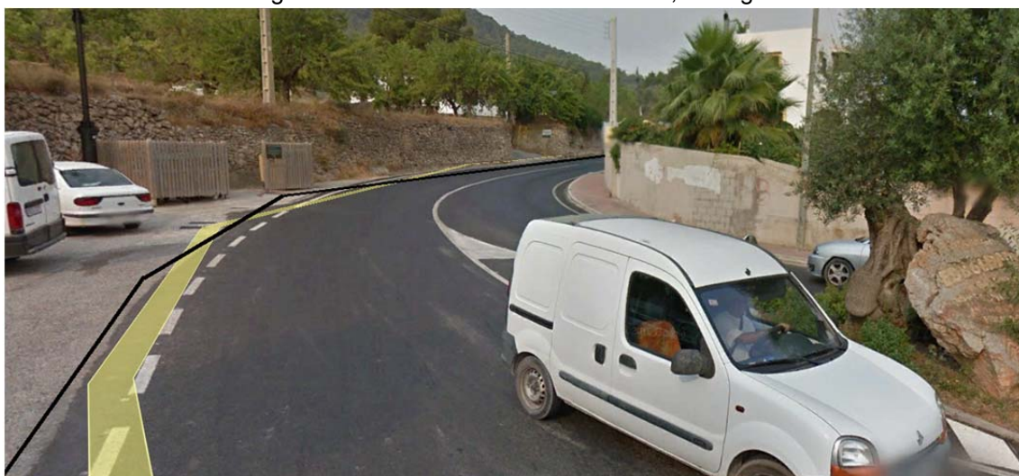
Imagen 11. Tramo 3: Localización aprox. conexión C3.
