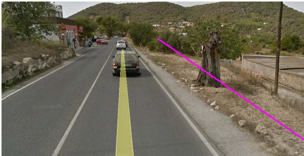
Imagen 8. Tramo 2. Paralelo PM-803. Interferencia árbol.
