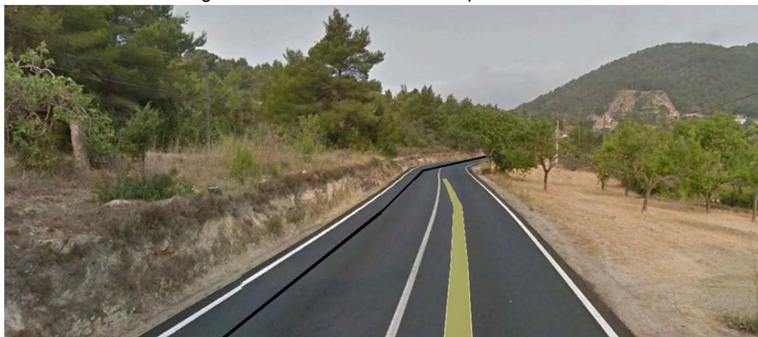
Imagen 15. Tramo 3. Localización aprox. Desagües.
