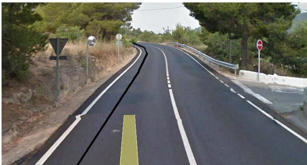
Imagen 13. Tramo 3. Localización aprox. conexión C4.
