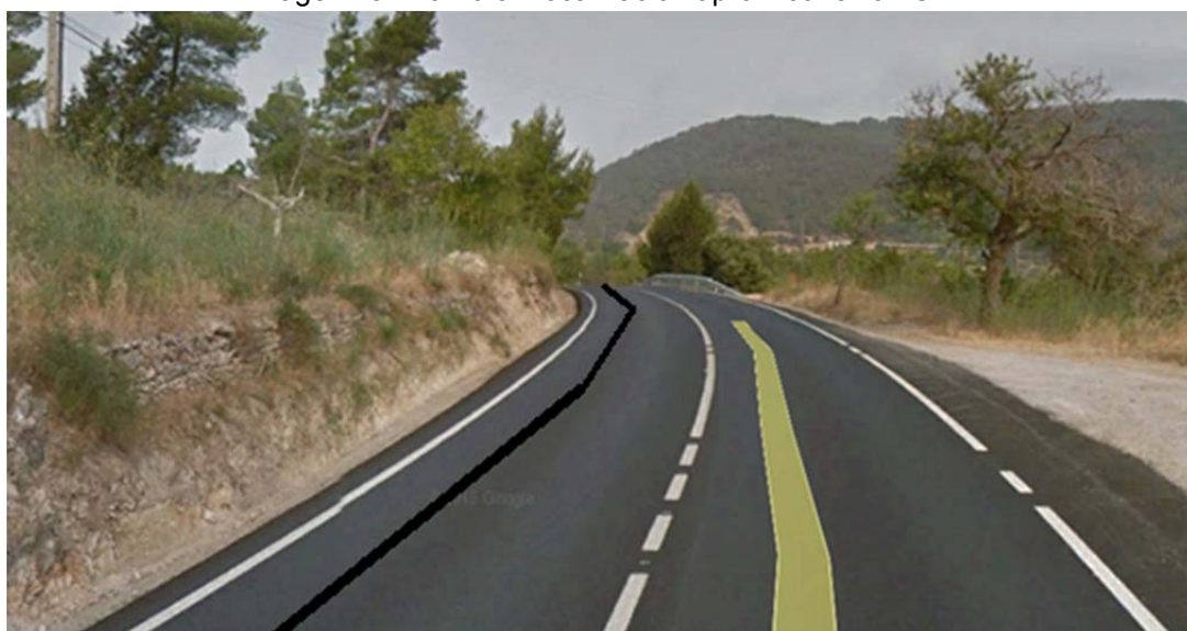
Imagen 14. Tramo 3. Localización aprox. Ventosas.
