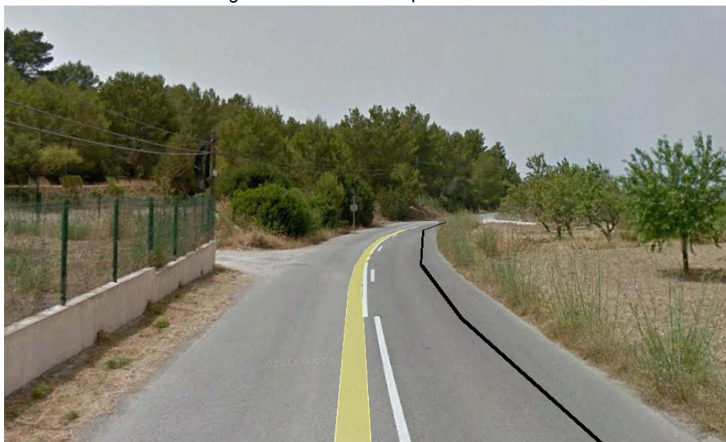
Imagen 23. Localización aprox. Ventosas.C7.
