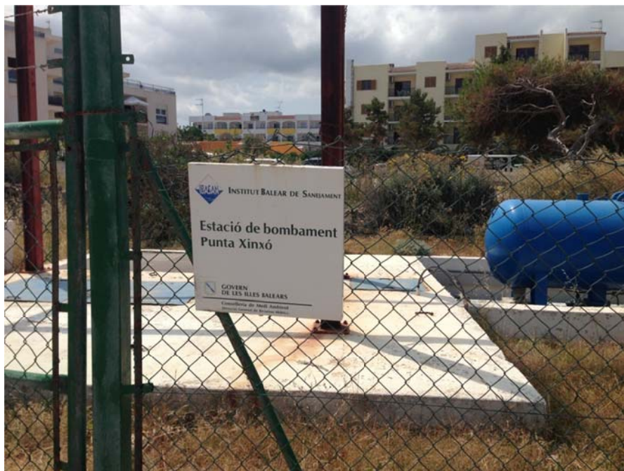
ACCESO BOMBEO PUNTA XINXÓ
