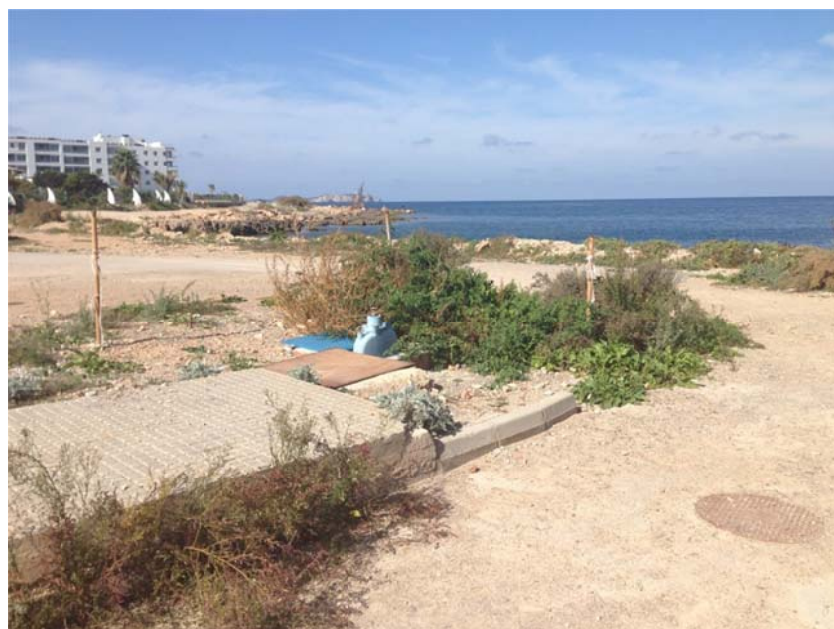
PUNTO DE UNIÓN DEL EMISARIO TERRESTRE-MARÍTIMO
