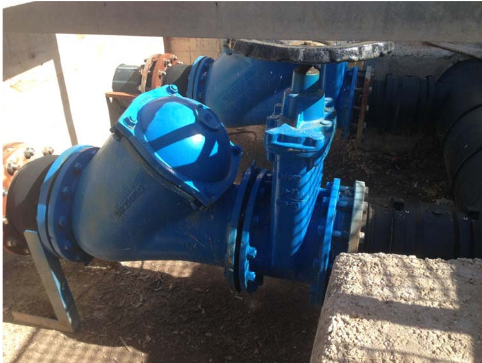
VÁLVULA ANTIRRETORNO DE BOLA DN 250
