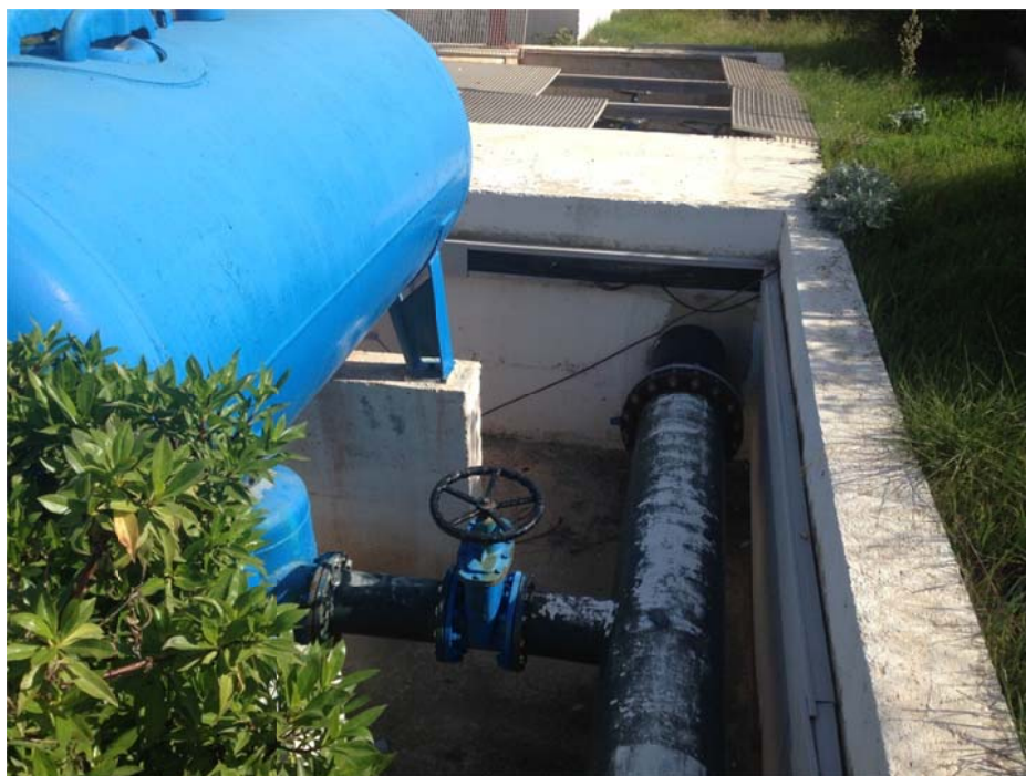
VISTA CALDERÍN Y VÁLVULA
